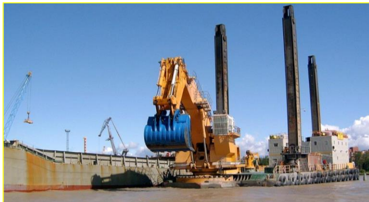
Abbildung 1-1: Tieflöffelbagger mit Stelzen
